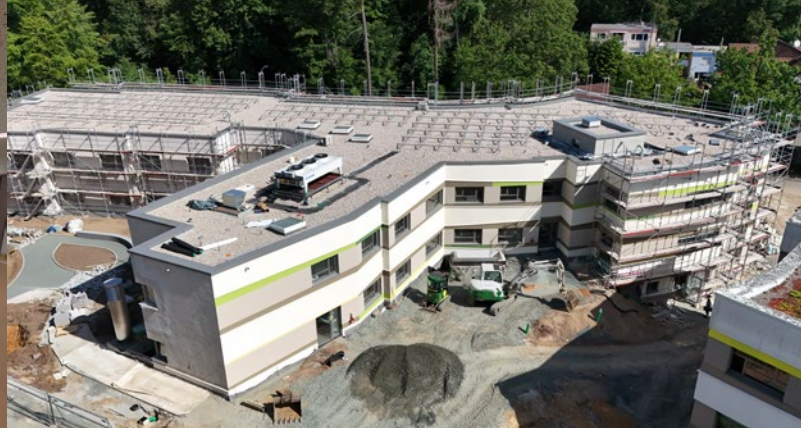
Neues Haus Altkönig: Baustelle im Mai 2026
